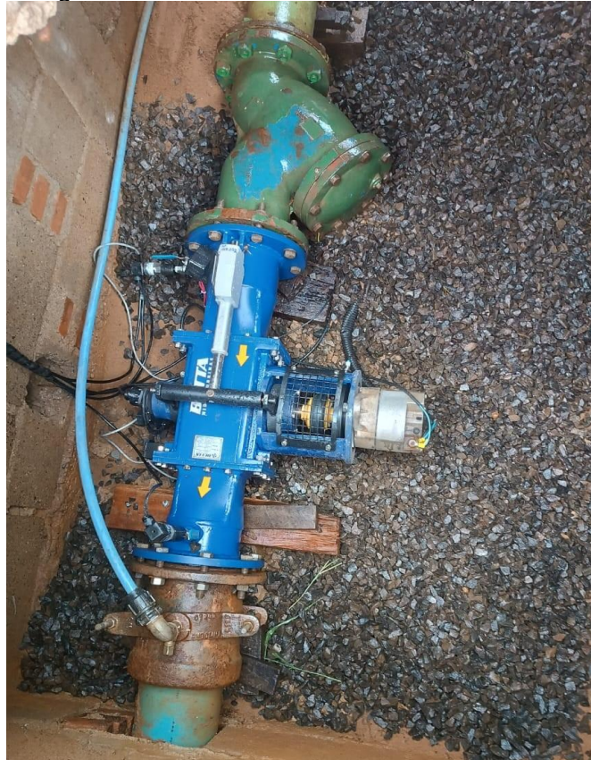
Imagem 9 - TRP instalada em substituição a VRP
