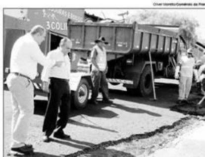
INSPEÇÃO - O secretário de Desenvolvimento e Saúde, Alexandre Ferreira, e o prefeito Sidnei Rocha acompanham trabalhos de equipe da Emdef em rua do Jardim Paulistano
